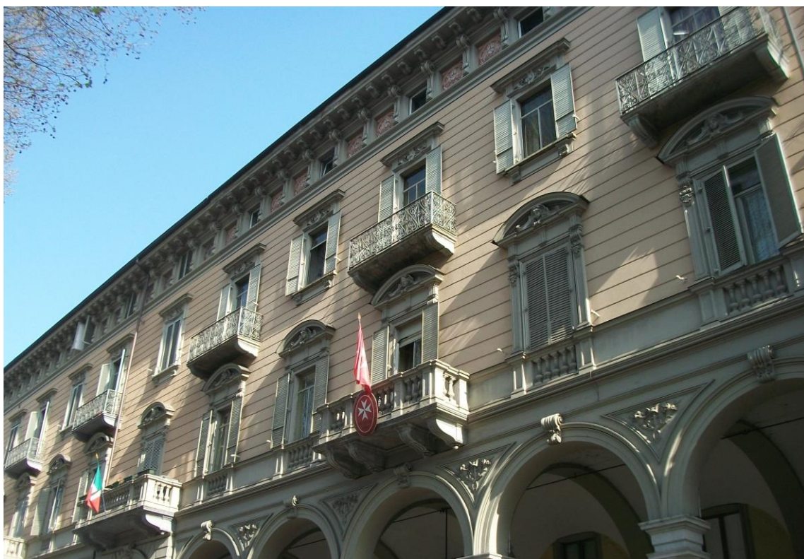
Delegazione del Piemonte e della Valle d'Aosta, sede di Corso Vittorio Emanuele II 96, veduta esterna
