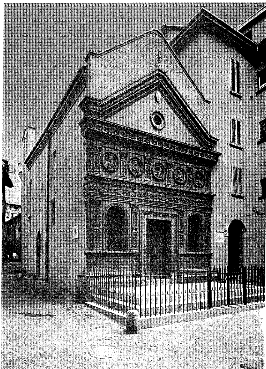
La Facciata e il Fianco dopo i restauri (1965)
